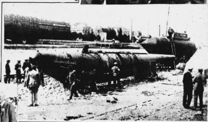
FRANCIA —He aquí el Oceanografo, nuevo aparato de navegación inventado por Adrien Remy. Este aparato de 75 pies de longitud, está equipado con un motor de 700 caballos. Remy se propone cruzar el Atlántico en su retrete bagas.
